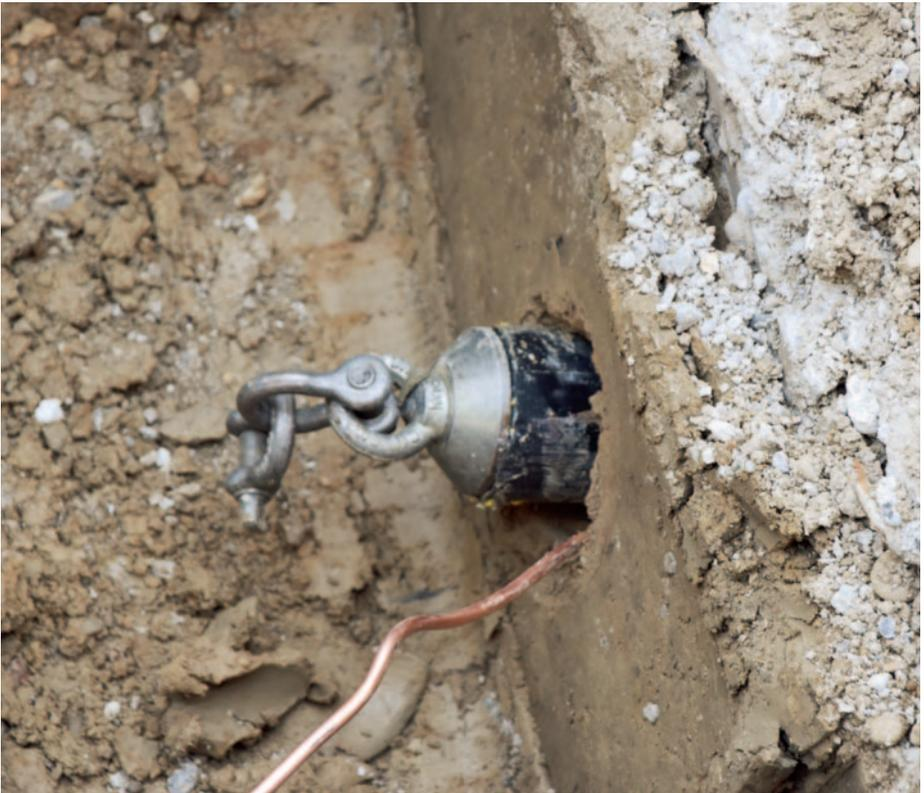
Die Verlegung von Rohren erfolgt grabenlos ohne Eingriff an bestehenden Gartenanlagen oder Behinderungen von Verkehrswegen. Auch in schwierigen Geländeformen können Rohre oder Rohranlagen anstelle von konventionellen Ausführungen grabenlos verlegt werden.
