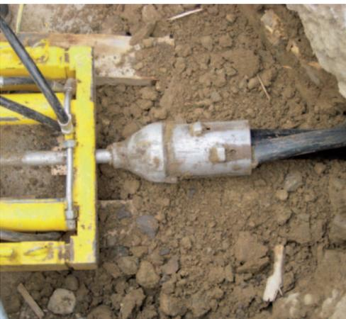
Ankunft am Installationsort, der Rohreinzug ist fertig erstellt. Es können Leitungen bis zu einem Durchmesser von 125 mm und ca. 30,00 m Länge grabenlos verlegt werden. Je nach Bodenbeschaffenheit sind grössere Durchmesser und längere Strecken möglich.
