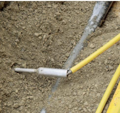
Im Ziel angelangt wird der Pilotkopf entfernt und durch eine Aufweitglocke ersetzt. Nachfolgend wird das Rohr und wenn nötig ein Erdungsdraht angekoppelt. Beim Rückzug des Gestänges wird das Schutzrohr in den Boden eingezogen.
