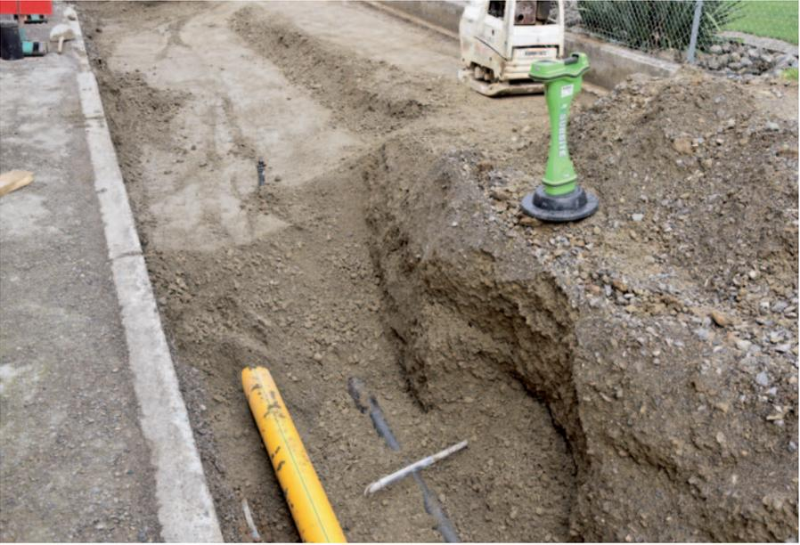
Mittels Ortungsgerät wird die Lage der Pressspitze regelmässig kontrolliert, am Boden markiert und eine Korrektur eingeleitet. So ist eine kontrollierte, zielgenaue und präzise Pressung möglich.
